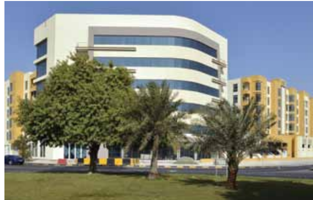
مبنى المكاتب في دانات المدينة
